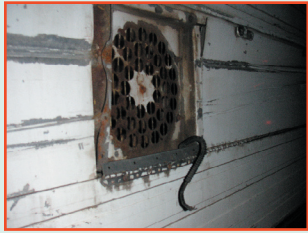
Un ventilateur brisé peut avoir de très graves conséquences. Vérifier que tous les ventilateurs marchent.
